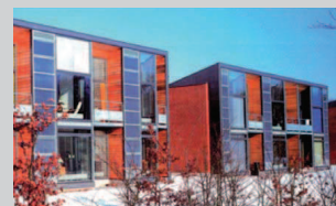
Inserimento di serre e pareti di accumulo
