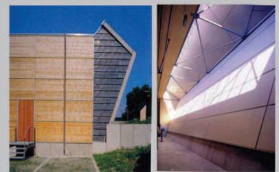
Superfici vetrate inclinate poste nelle coperture dei fabbricati portano la luce riflessa nelle zone interne ove non sia possibile praticare aperture nelle facciate.
