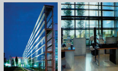
Inserimento di soluzione a doppia pelle per aumentare il comfort interno.
