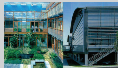
Trasformazione tipologica al fine di aumentare il comfort (atrio interno) e ridurre l'uso di suolo (piano pilotis ad uso parcheggio).
